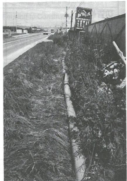
写真10.2 塩化ビニル管による地上仮配管（長万部町）
