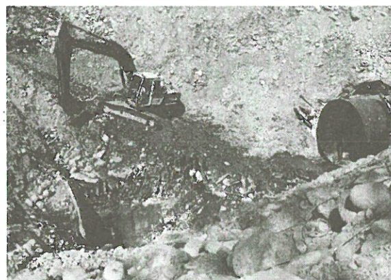
写真 3.1.15 取水トンネルの復旧状況 (右が石岡ダム側で4m 隆起)
