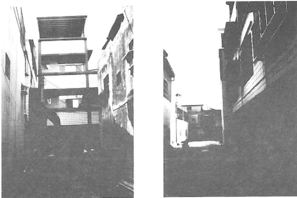
写真-4.2.3 液状化により傾斜した建物
