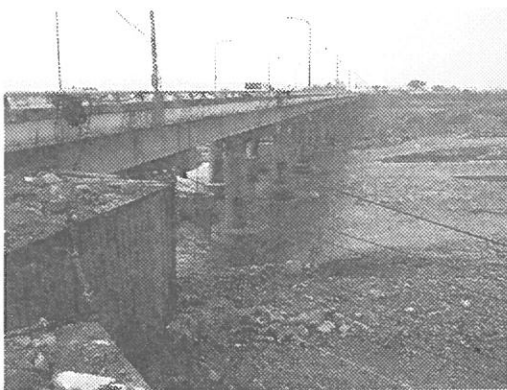
写真 3.2.10-3 名竹大橋（橋脚は 2 本の円柱橋脚）
