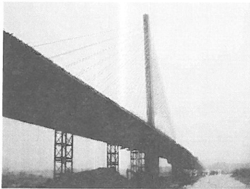
写真 3.2.11-1 集鹿大橋 (建設中の斜張橋 : 写真提供佐藤氏)
