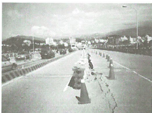
写真 3.2.4-3 東豊大橋 (桁部に縦亀裂が見られた : 写真提供佐藤氏)
