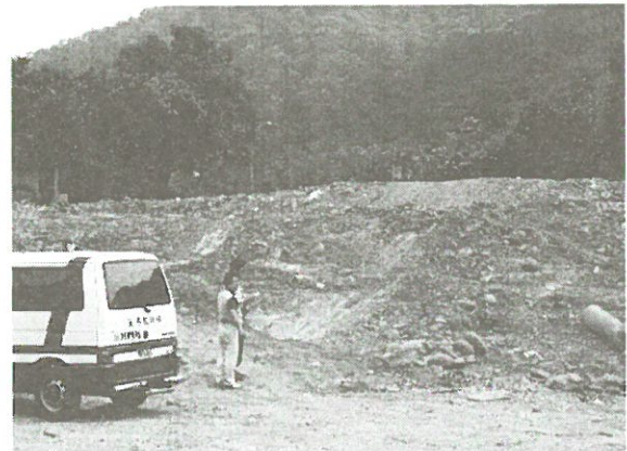
写真 3.1.22 復旧した送水管の被害箇所 (第一浄水場の資材運搬通路)
