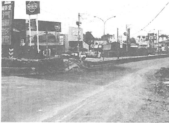
写真 3.1.37 ガス輸送導管の被害地点 (写真手前 200m に烏溪橋)
