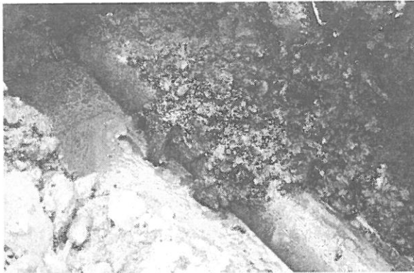
写真 3.1.25 水道管の復旧作業 (豊原市街：塩化ビニル管)
