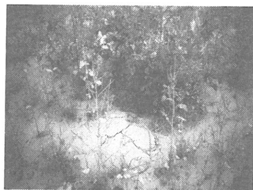
写真 3.2.8-2 溪頭橋 (河床に液状化による噴砂孔)
