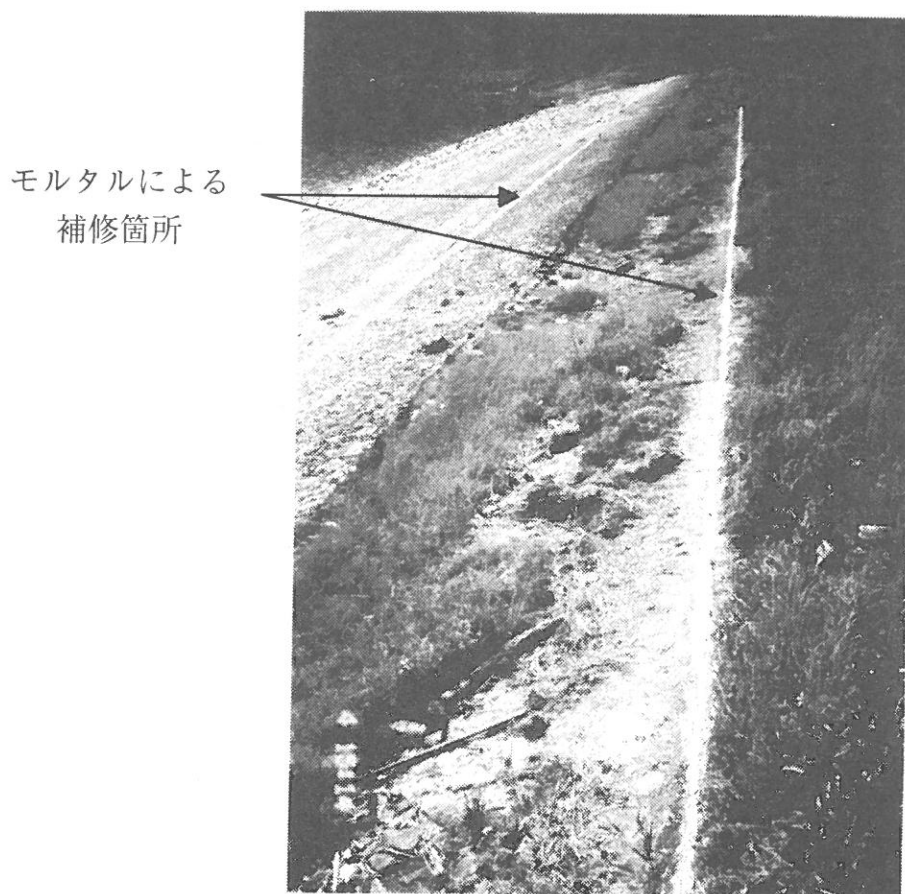
写真-5.1.1 水社ダム上流側の亀裂の補修状況
