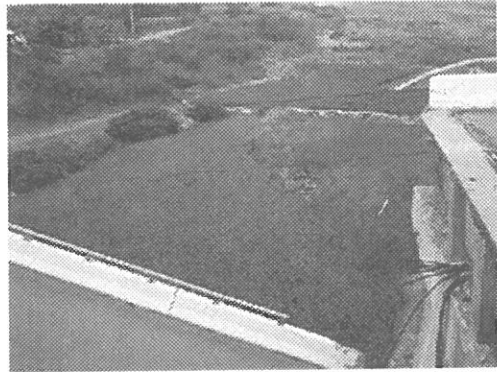
写真 3. 2. 6-4 烏溪橋 (河床の断層変位)
