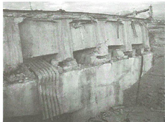
写真 3.2.2-4 長庚大橋 (5 主桁、ゴム支承、支承部のストッパーの損傷の程度は激しくない)
