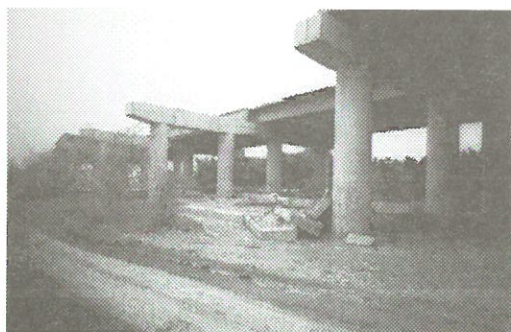
写真 3.2.7-1 中部第二高速公路（建設中の高速道路高架橋）
