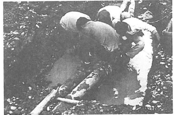
写真 3.1.26 水道管の復旧作業 (道徳高専入口：塩化ビニル管)
