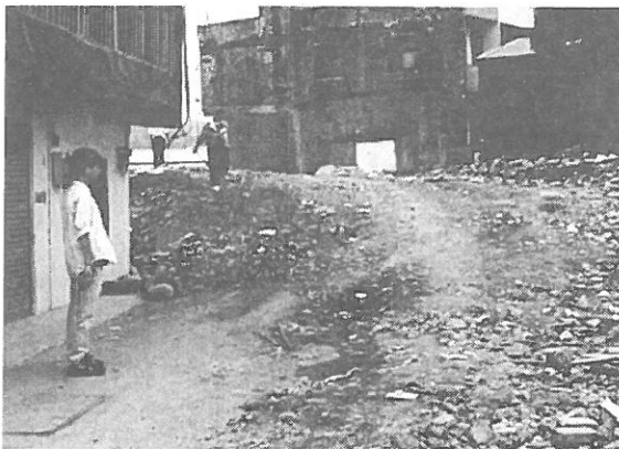
写真 3.1.39 被害地点付近の断層変位 (鉛直変位は約 1.5m)
