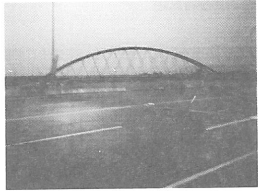
写真 3.2.12-4 緑美橋 (桁が西側に 30~ 40cm ずれた)
