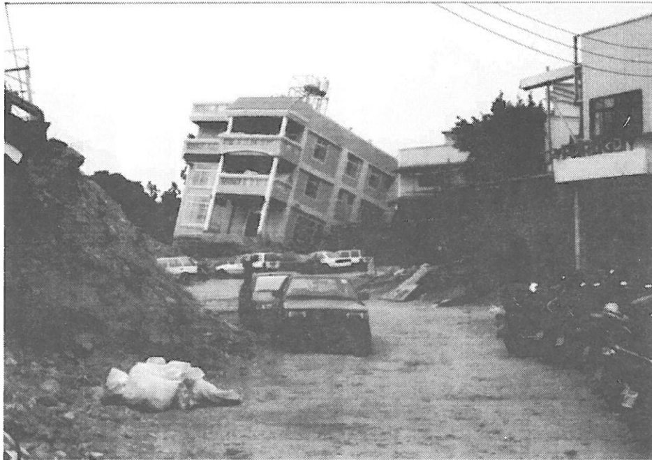
写真-3.3.3 地震断層と傾いた建物
