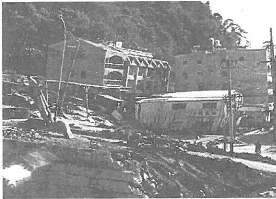
写真 3.1.3 一号橋左岸側の断層変位と被害 (左側が断層の上盤側にあたる)
