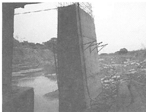
写真 3.2.5-2 一江橋 (新橋の橋脚が建設中であった)
