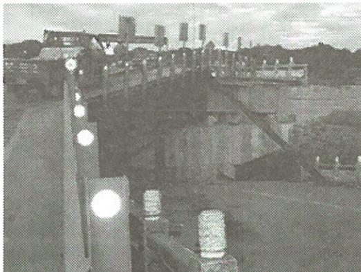
写真 3.2.2-3 長庚大橋 (仮橋が架けられていた)
