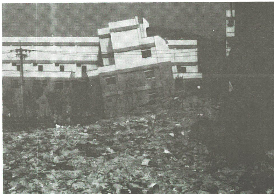
写真-3.3.1 断層による建物被害
