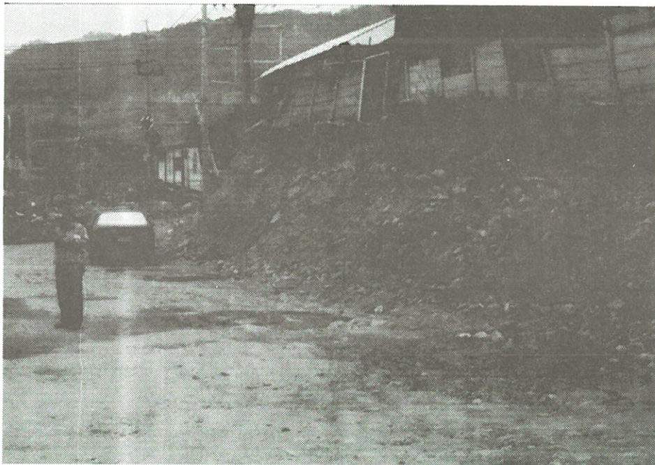
写真-3.3.2 一江橋西の地表地震断層
