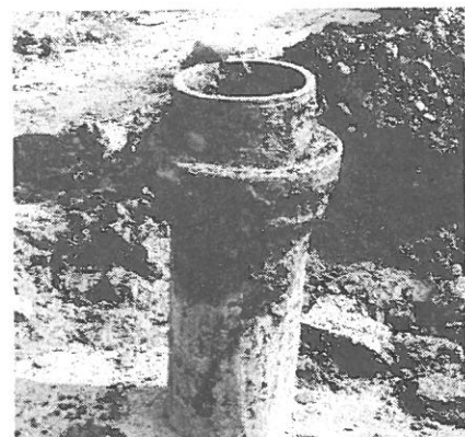
写真 3.1.28 水道管の復旧作業 (員林：切断された鑄鉄管の継手部)
