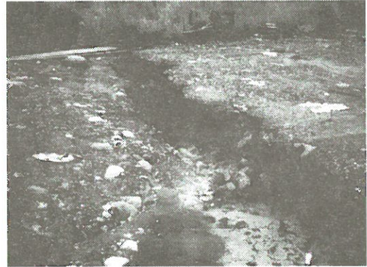
写真 3.2.11-6 集鹿大橋（河床に液状化によって発生したと考えられる噴砂孔と地盤が陥落した跡があった）
