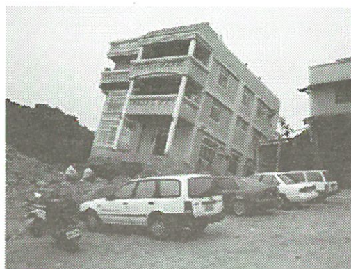
写真 3.2.5-6 一江橋 (左岸側にある建物が断層変位により大きく傾斜)
