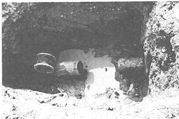
写真 3.1.27 水道管の復旧作業 (員林：鑄鉄管の継手部を切断)
