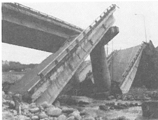
写真 3.2.3-3 石圍橋(東勢側の桁が2橋とも落橋:写真提供佐藤氏)
