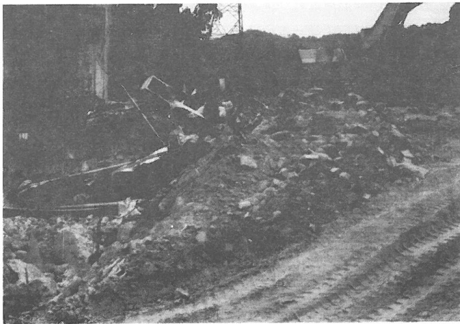
写真-3.3.5 霧峰における地震断層と家屋の被害の様子
