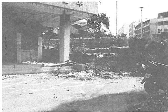
写真 3.1.45 鎮公所における断層変位 (断層変位は約 1.5m)
