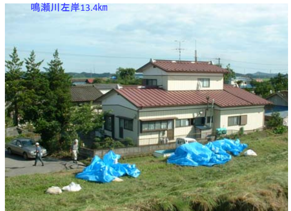
鳴瀬川左岸13.4km
