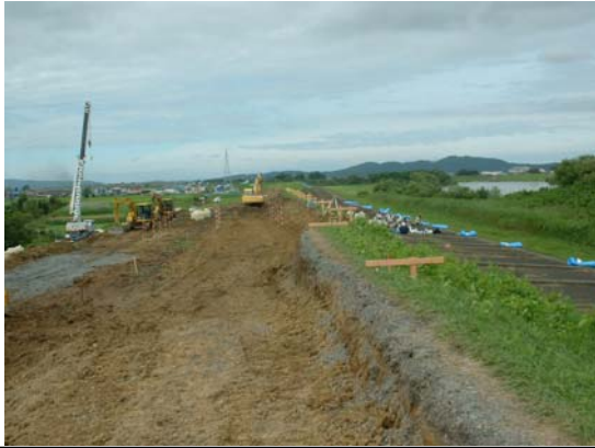
鳴瀬川右岸13.0km
