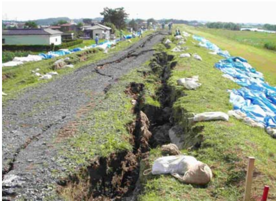
鳴瀬川左岸13.4km
