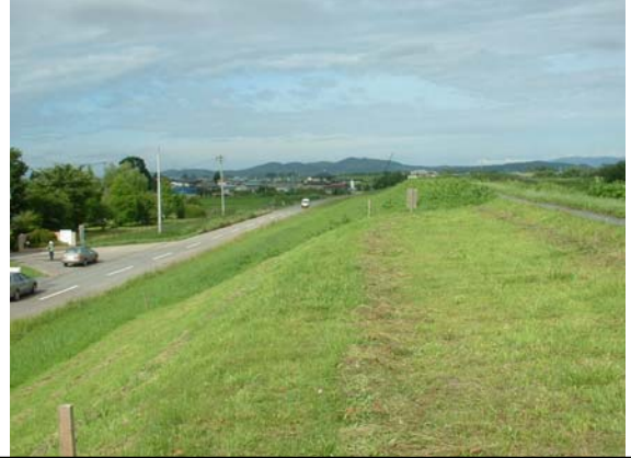
鳴瀬川左岸12.1km
