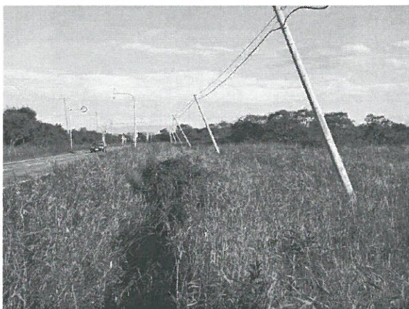
写真-11.3.3 電柱の傾斜状況
