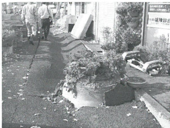
写真-13.11 悠久町の人孔浮上がり被害
