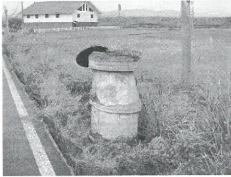
写真-13.7 大きく浮き上がったマンホール (小千谷市)
