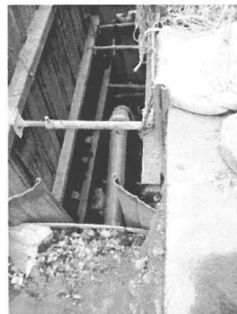
写真-13.19 浮き上がった下水道管の復旧状況（長岡市町田町）
