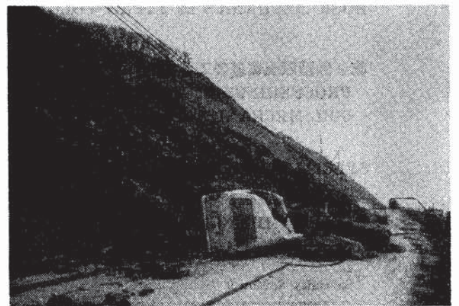
写真-6 静内町入船地区での斜面崩壊
