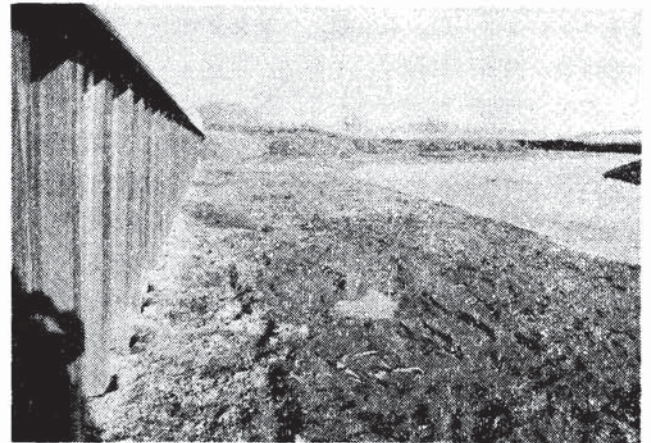
写真-2 有良川河口の矢板前面に見られた噴砂
