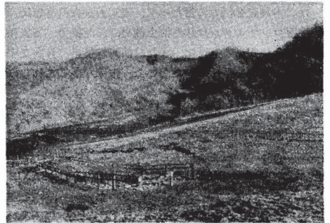
写真-5 静内町東静内での牧場斜面の被害
