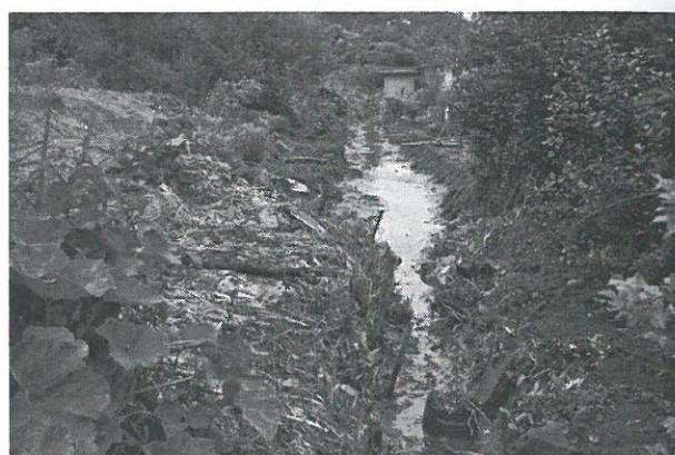
写真 3.7.8-8 閉塞後に開削された i 宅裏の水路
