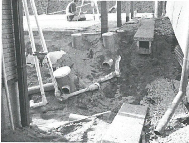
写真 3.7.7-1 宅地内に生じた段差 (図 3.7.7-2 の Photo(A)) (写真 3.7.2-3 の家屋の別アングル)
