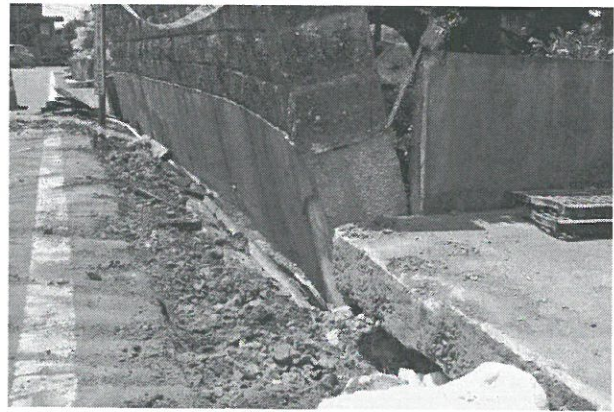
写真 3.7.8-11 玉突き状に押された下段 (o 宅)
