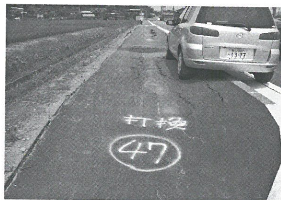
写真 5.9.2-4 2007 年新潟県中越沖地震における刈羽村十日市地区の無被災状況
