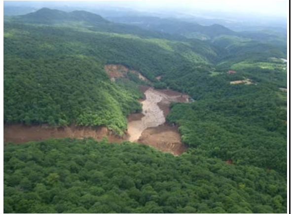
(6) 駒ノ湯の上流から駒ノ湯をのぞむ
