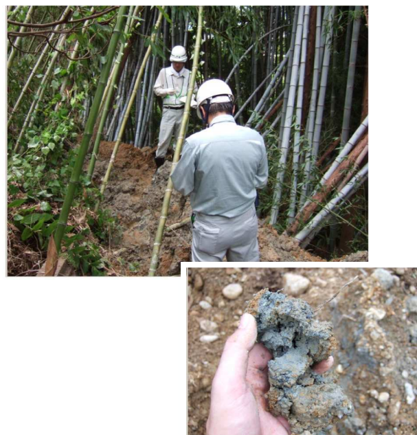
写真-3 崩積土先端付近の孟宗竹と粘性土
