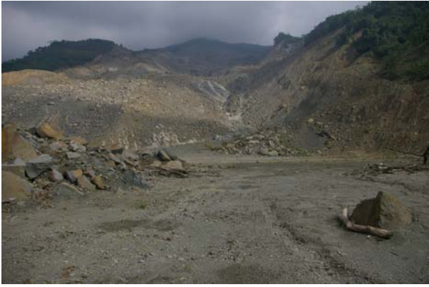
写真-3.39 左岸側斜面崩壊の中間地点
