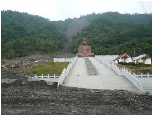
写真-3.20 彩虹山大佛後背斜面の崩壊状況
