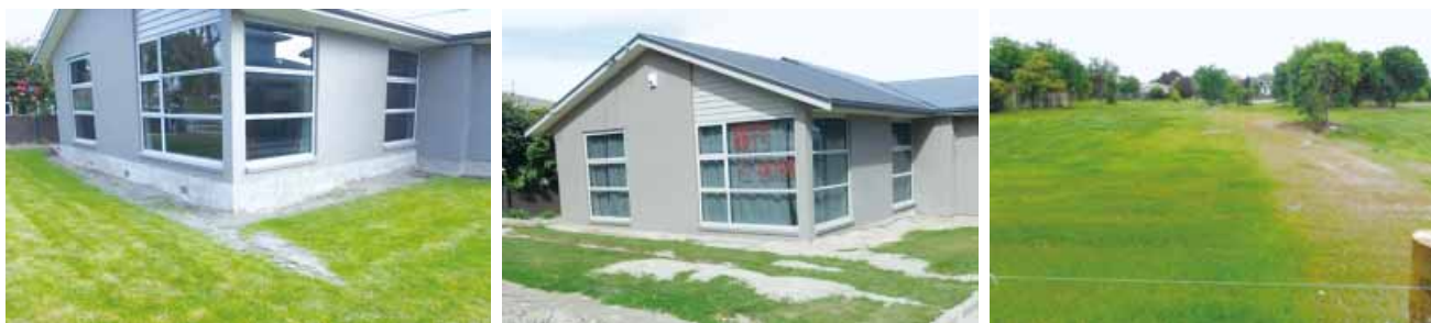
(1) 2010年9月の地震(約20cm沈下)
