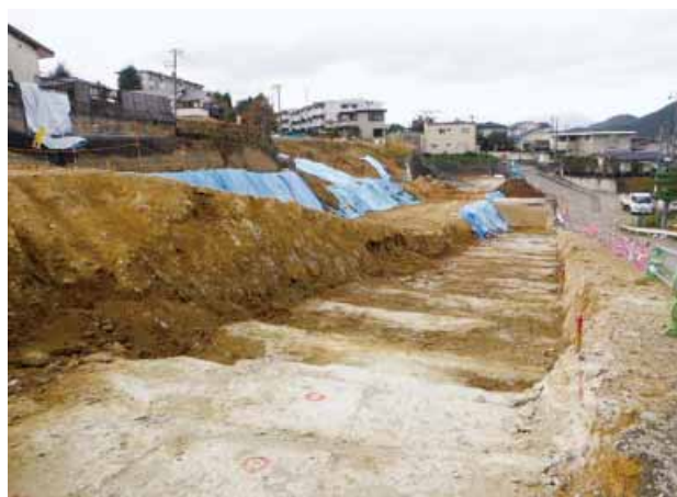
写真-6 折立5丁目の工事状況
