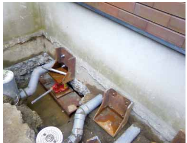
写真-5 液状化で沈下した家を持ち上げている状況(浦安市内)
