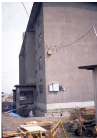
写真-1 1983年日本海中部地震の際に能代市で沈下したマンションを持ち上げて復旧している状況
