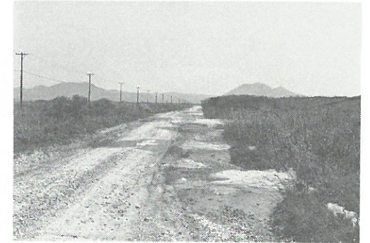
写真4.18 大潟橋南方の砂利敷道路における噴砂
