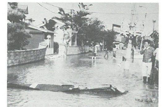
写真4.29 車力村下牛潟地区の液状化による浸水状況 (青森県提供)
