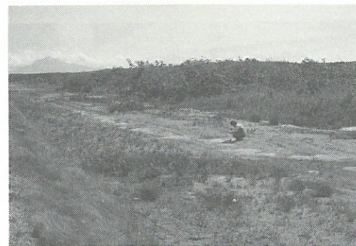
写真4.33 三吉山付近における国営屏風山開拓建設事業地域幹線道路に平行して連なる噴砂列
