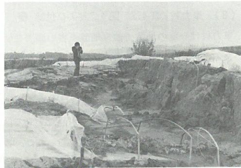
写真4.31 車力村下車力の畑地において発生した開口亀裂内の噴砂と向かって左側の地盤の陥没によって生じた約1.5mの段差
