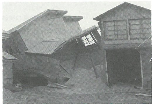
写真 4.38 車力村富苑山の上地区において全壊した建物の一例
