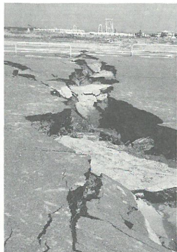
写真4.10 秋田港外港地区にある倉庫脇の駐車場で発生した開口亀裂内の噴砂
