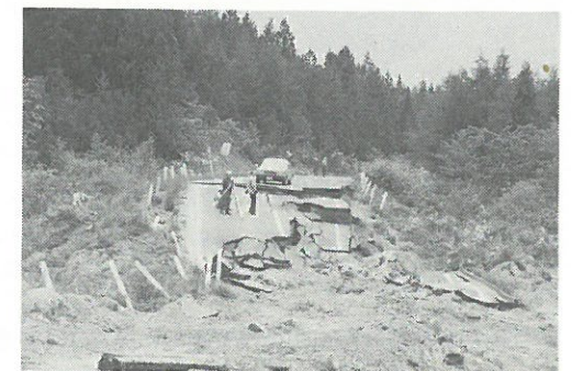
写真4.2 山地における道路被害の一例 (東津軽郡今別町大川平)
