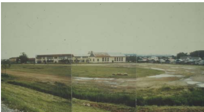
武田小学校、余震後
