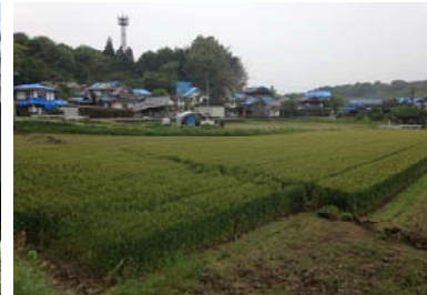
写真8 益城町に生じた横ずれ断層
