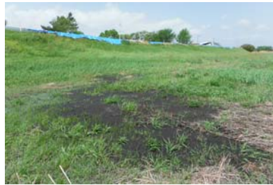
写真4 緑川右岸 8.8k 付近の河川敷で見られた噴砂
