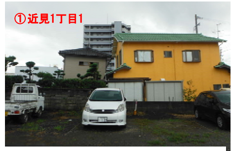
写真9 近見1丁目における液状化被害(その1)
