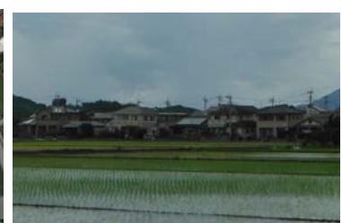
写真15 甲佐町芝原における戸建て住宅の沈下・傾斜
