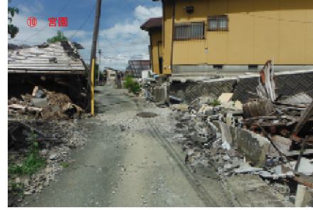
写真20 益城町宮園で震動によって壊れた住宅
