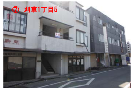
写真11 刈草1丁目における液状化被害
