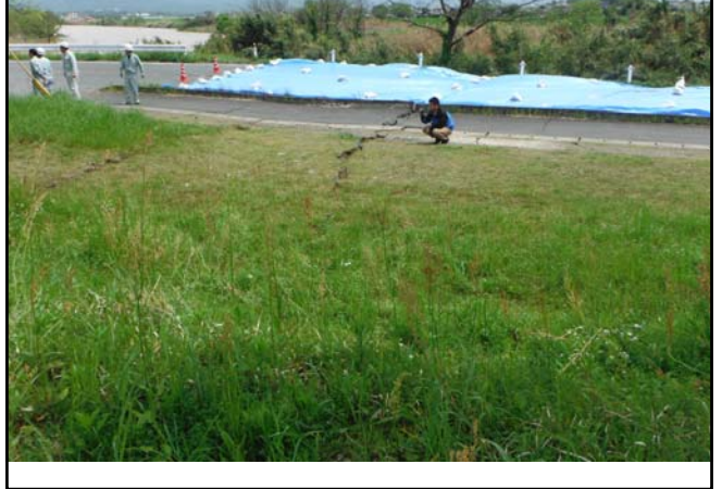
河川堤防 加瀬川R9.8k
