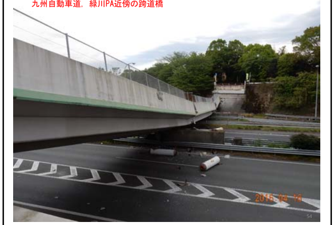
九州自動車道、緑川PA近傍の跨道橋
