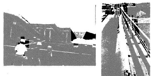
地盤の側方流動 新潟市昭和大橋[1964年新潟地震]
