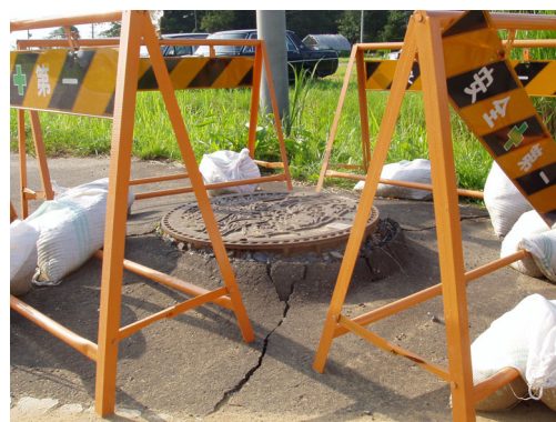
写真 2 マンホール No. 13 の写真
