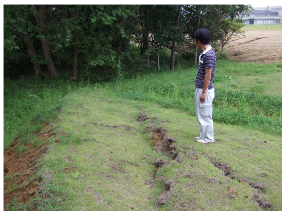
写真 6 山王遺跡の亀裂の写真 (9/26 山口撮影)
