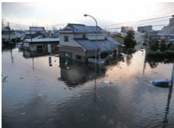
写真-2 津波で湛水した状況
